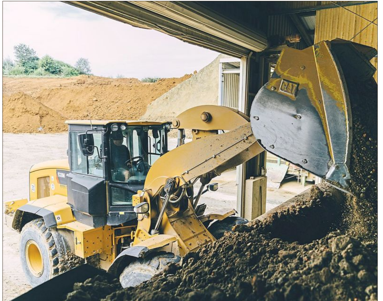
Leipfinger-Bader hat Wasserstoff unter anderem für die interne Logistik als Antriebstechnologie von Erdbaumaschinen und Gabelstapler im Fokus. Ein weiteres Themenfeld ist die Herstellung von grünem Wasserstoff mit dem Strom aus Photovoltaikanlagen.
